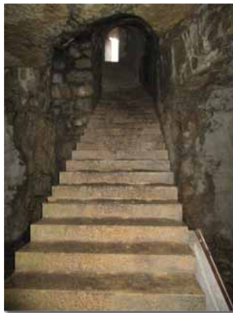
Fort-les-Bancs : escalier intérieur partant du magasin n°8 le plus à droite (voir ci-contre).
